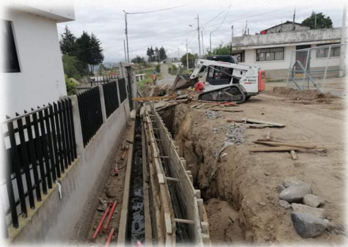
Mejoramiento del muro de contención de ciclópeo del Barrio Curiquingue
