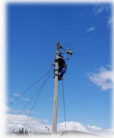
Instalación lámparas Laguinato
