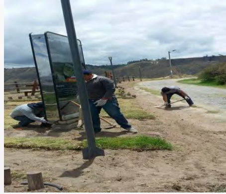
Instalación lámparas e iluminación en el mirador de los dos ríos.
