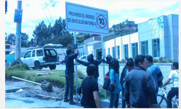
Señalización vertical ingreso centro parroquial. $330.00
