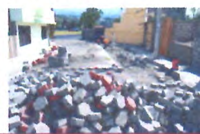
Adoquinado de las vía de ingreso a Nagsiche y en la ex línea férrea del Centro Parroquial
