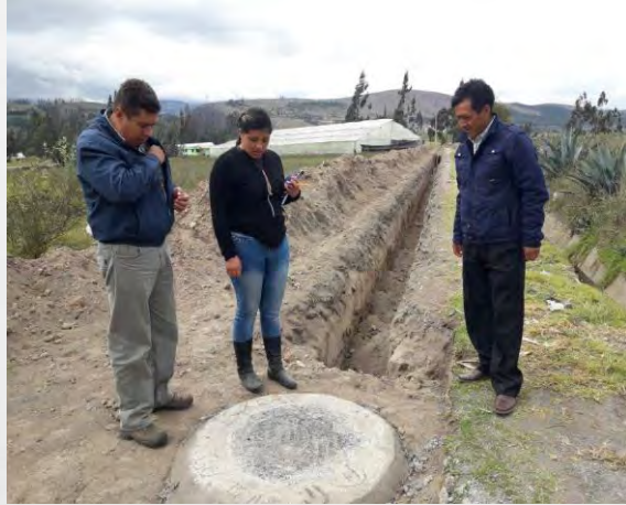
Extensión de red de alcantarillado Lampata Chasqui
