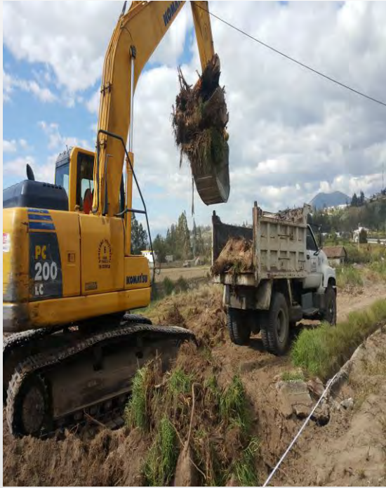
Ensanchamiento de la vía Los Guarangos Comunidad La Delicia.
