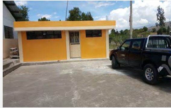
Mejoramiento baterías sanitarias. $5620.43
