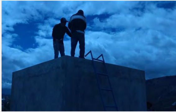
Mano de obra construcción tanque de agua potable. $2016.00
