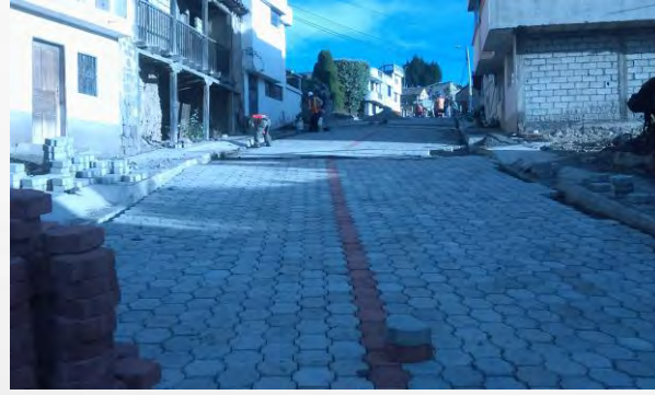
Adoquinado vía de ingreso Nagsiche (mano de obra). $5319.33
