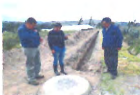
Extensión de red de alcantarillado Lampata Chasqui
