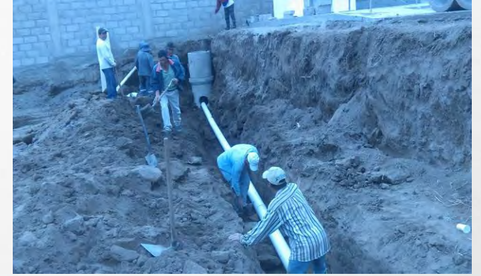
Tubos y accesorios para empatar alcantarillado a baterías sanitarias.
