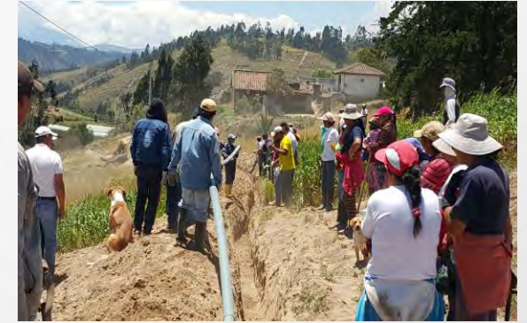
35 tubos PVC y pintura exterior casa barrial. $444.00
