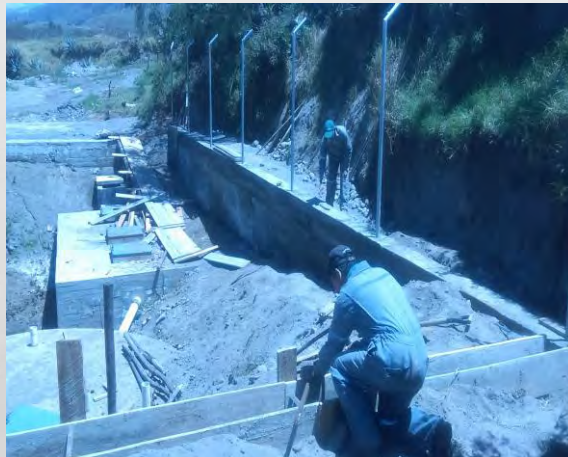
Cerramiento planta de tratamiento Comunidad de Tigualo
