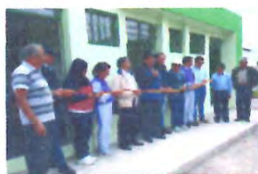
Construcción baterías sanitarias comunidad Tigualo
