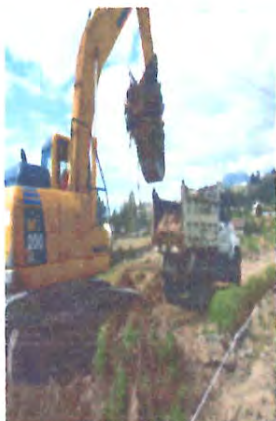
Ensanchamiento de la vía Los Guarangos Comunidad La Delicia.
