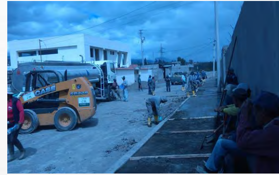
150mts. Encofrado para bordillo en la ex línea férrea. $960.34
