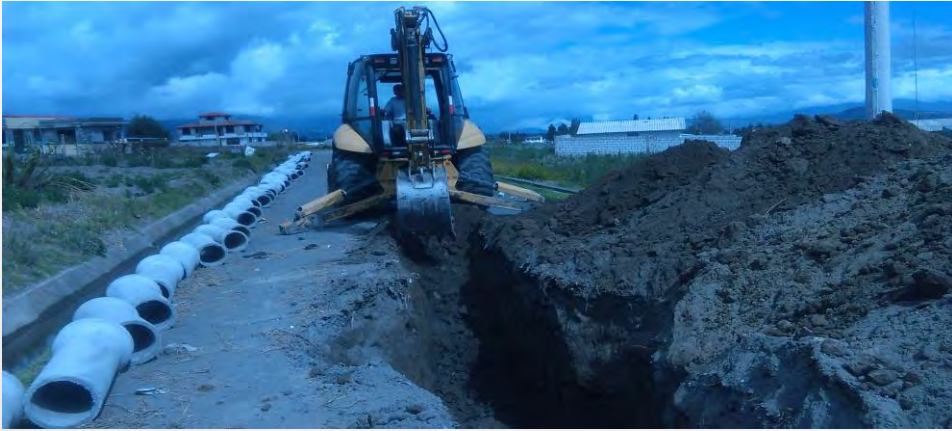
48 horas de retroexcavadora para alcantarillado
