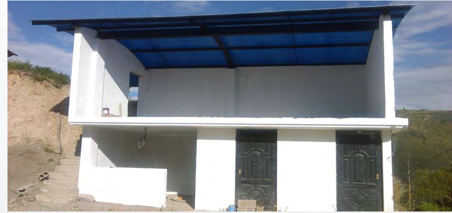
Construcción cubierta en la plazoleta de Pataín Sur. $3489.58
