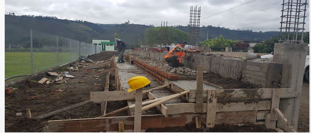
Construcción de graderíos en el estadio. $6108.23
