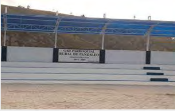
Construcción de graderío y cubierta en el Calvario. $23925.28
