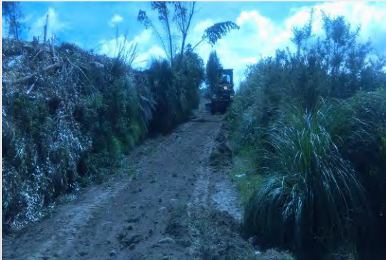
7 horas retroexcavadora limpieza vía Jacho – Tigualo. $159.60
